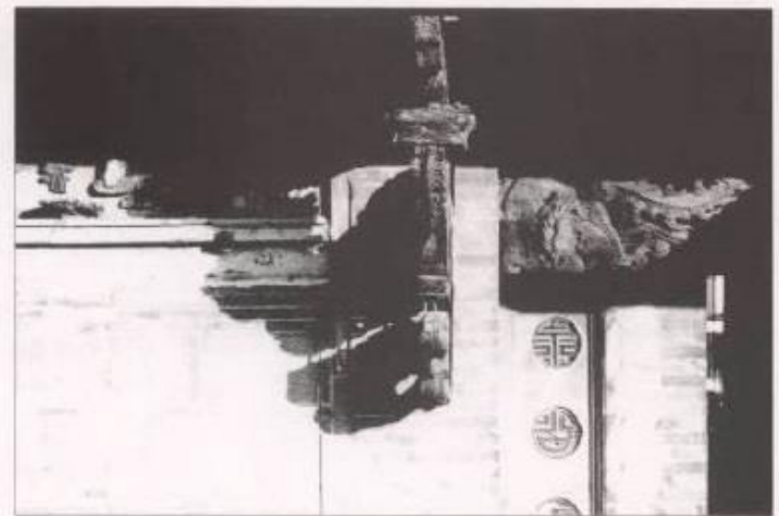
圖 040 嶺星山莊門樓背側磚柱及磚飾結構
